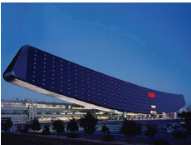
Σχήμα 3: Το ηλιακό τόξο στο Gifu της Ιαπωνίας. Η κατασκευή αποτελείται από ΦΒ πλαίσια και καλύπτει συνολικό μήκος 315 μέτρων με μέγιστο ύψος 37 μέτρα.
